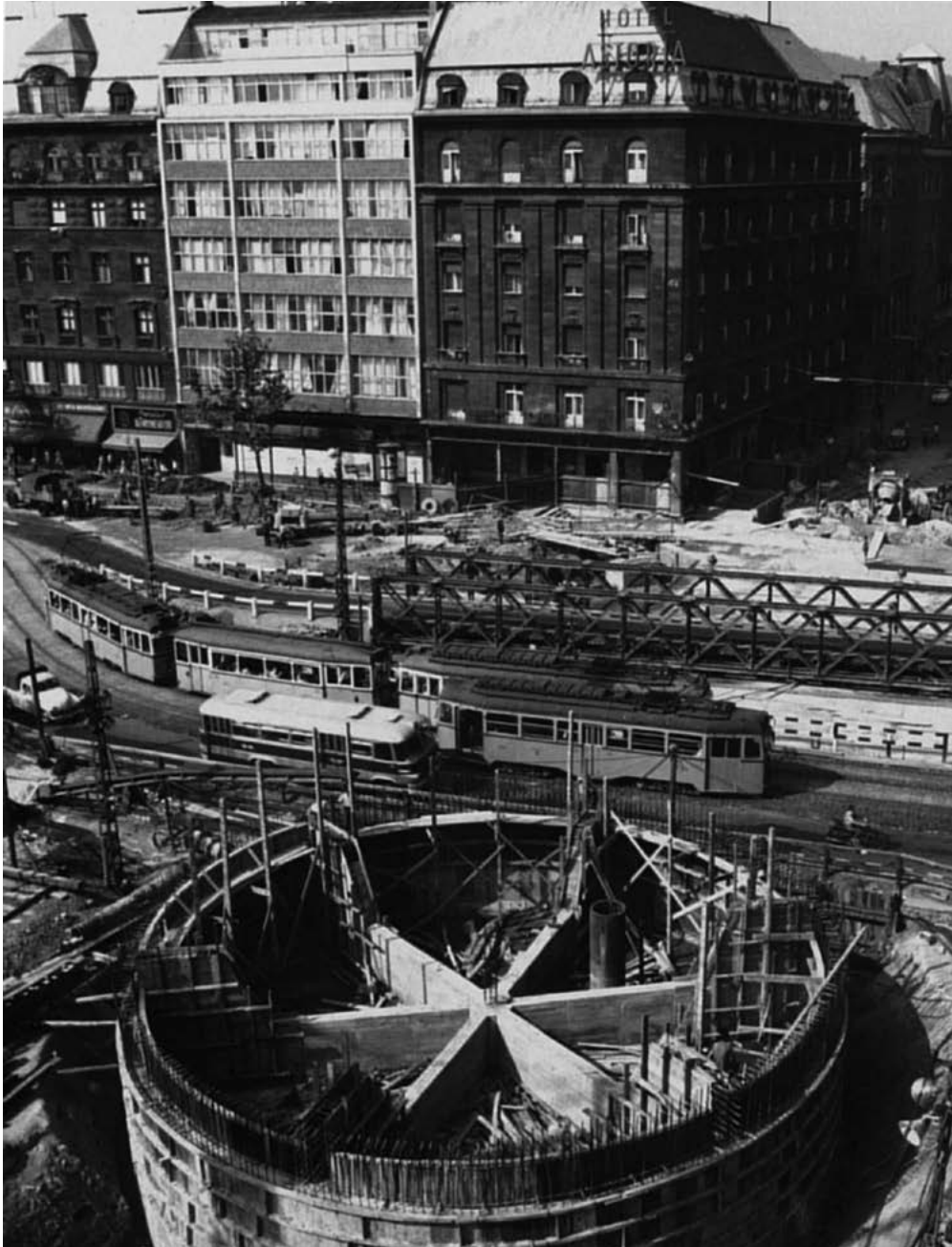
1963. november 30-án átadták a főváros első aluljáróját Erzsébetváros "sarkánál", az Astoriánál. Az építkezés alatt a forgalom a Zagyváról idetelepített hídon zajlott.
